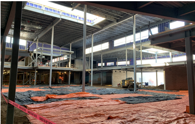
Central commons and cafeteria prep for SOG pour 11/18/2022
